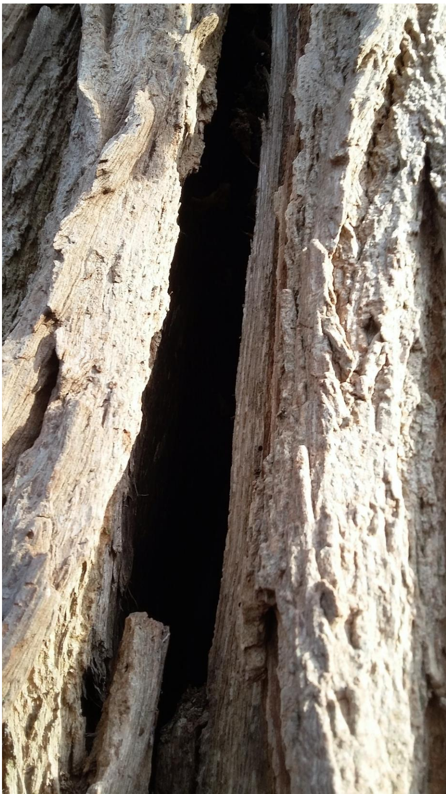
Figuur 4. Robinia met een diepe, niet volledig inspecteerbare holte.
