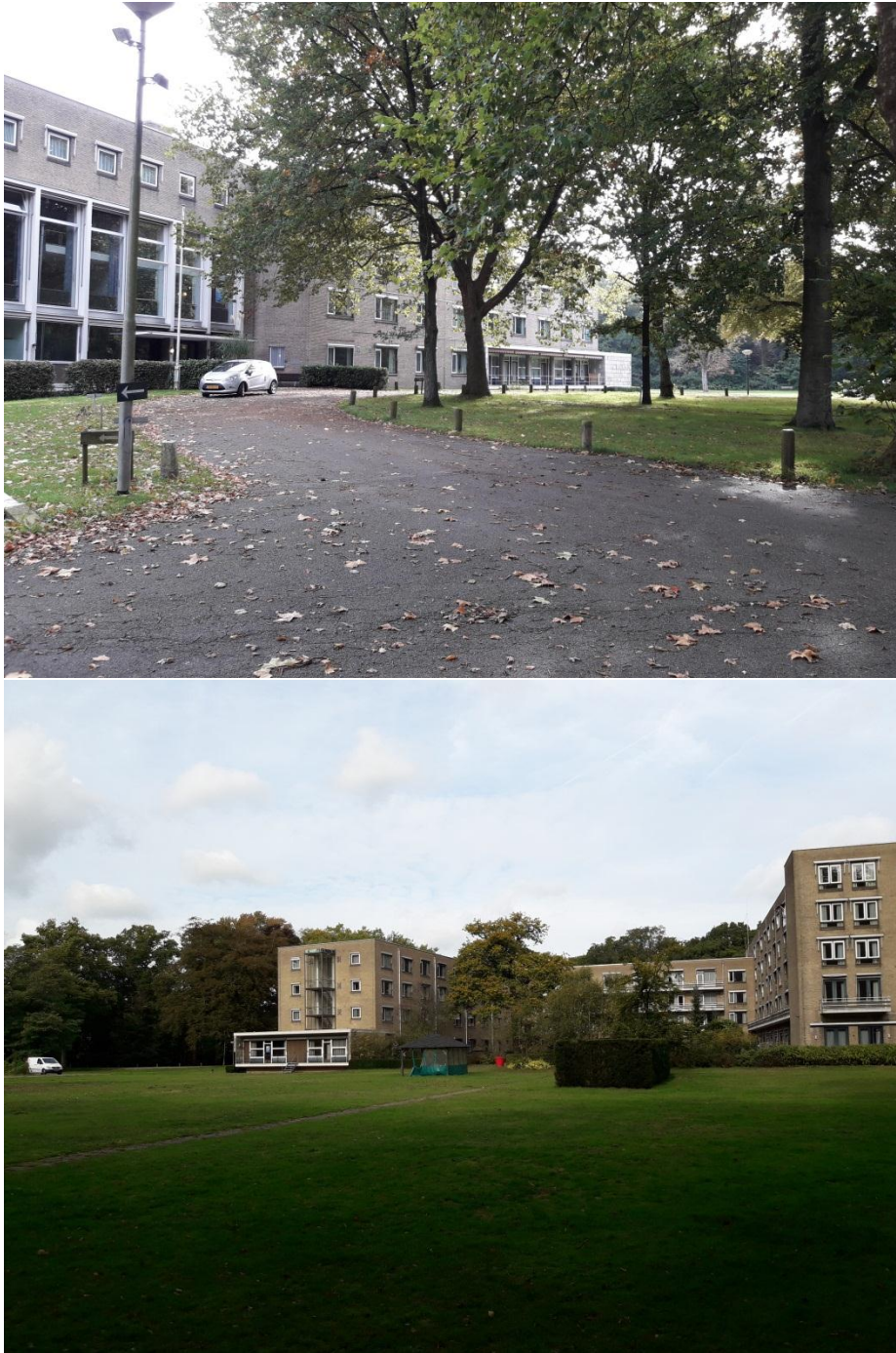
Figuur 3.2 Zicht op de hoofdingang van het gebouw vanaf het noordwesten in zuidoostelijke richting (boven) en zicht op het plangebied vanaf boring 4 in noordelijke richting.
