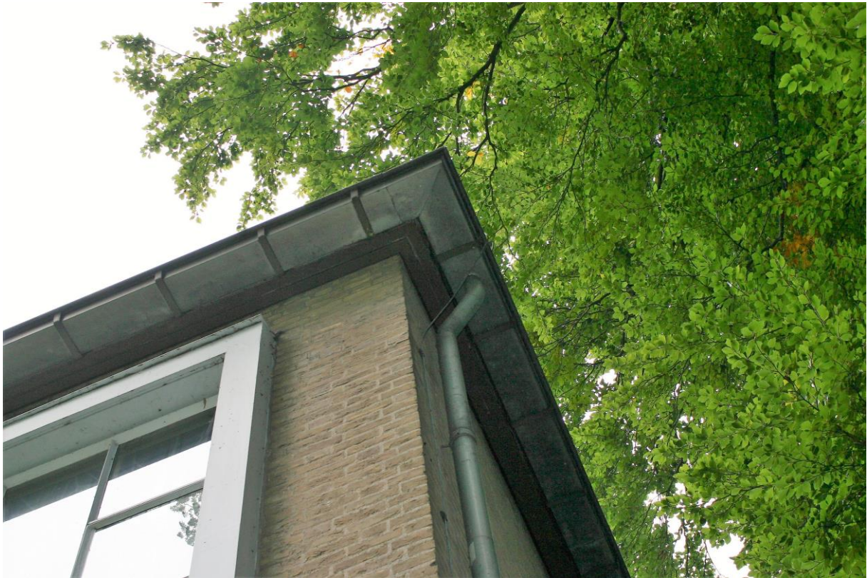
Figuur 21. De dakbetimmering van de kapel vertoont kieren, zodat hier mogelijk vleermuisverblijven aanwezig zijn.
