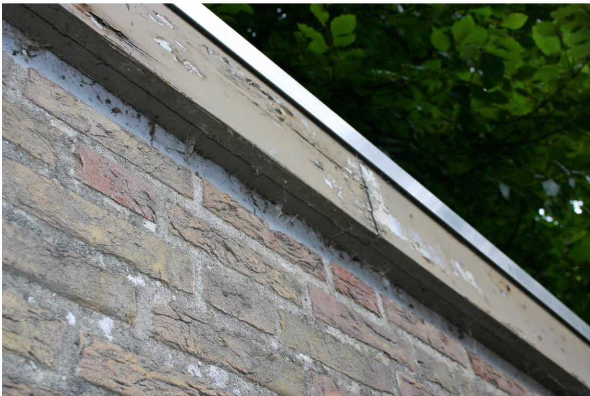
Figuur 23. De garageboxen hebben geen openingen of kieren; hier zijn geen vleermuisverblijven aanwezig.
