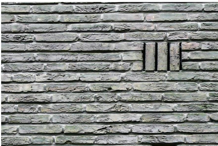
Figuur 18. Ventilatiesleuven geven vleermuizen toegang tot de spouw van het verzorgingstehuis.
