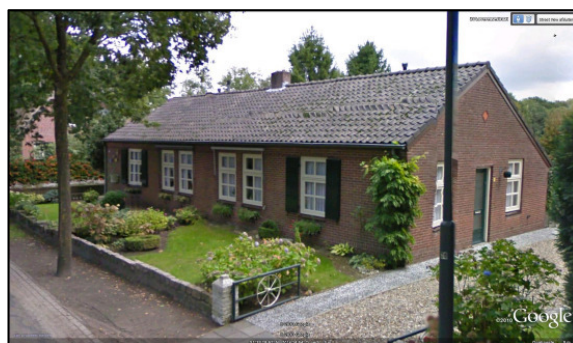
3.c huidige bebouwing deelgebied 2
