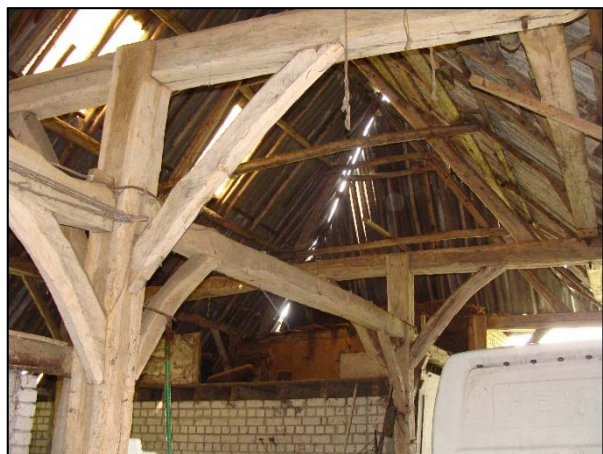
Foto 4. Binnenzijde Vlaamse schuur
