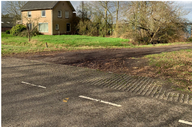
Overgang van hoofdweg naar onverharde zijstraat met de rammelstrook als onderbreking.
