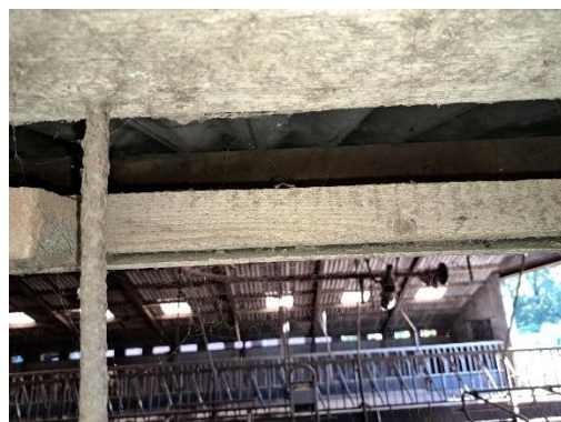
B. Opening tussen dak stal A.
