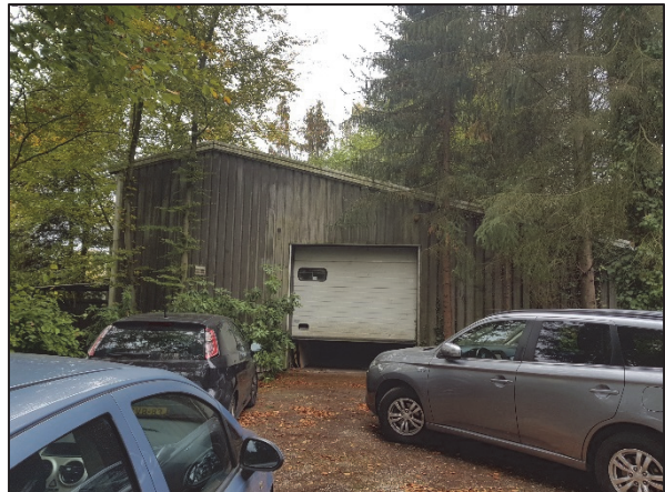
Figuur 3. Loods gezien vanaf noorden
