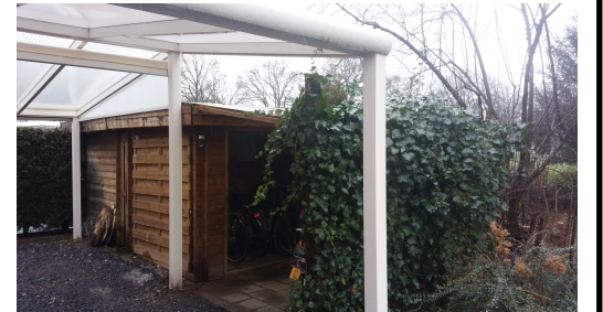
G/H/E Bijgebouw en overkapping
