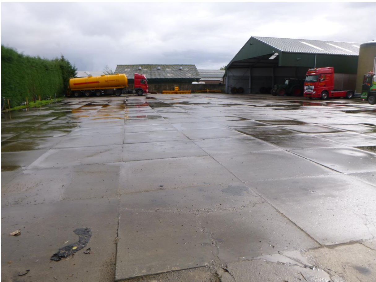
Figuur 21: Het met stelconplaten verharde westelijke deel van het plangebied gezien vanaf boorpunt 4 in zuidelijke richting.
