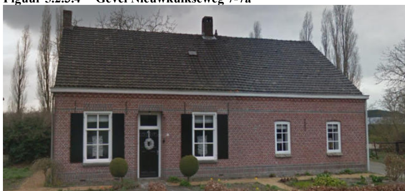
Figuur 5.2.3.5 Gevel Nieuwkuikseweg 6 – 6a
