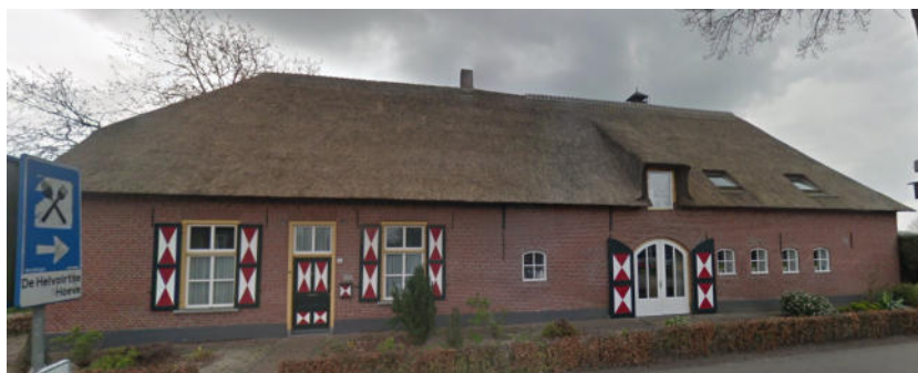
Figuur 5.2.3.3 Gevel Nieuwkuikseweg 8-8a
