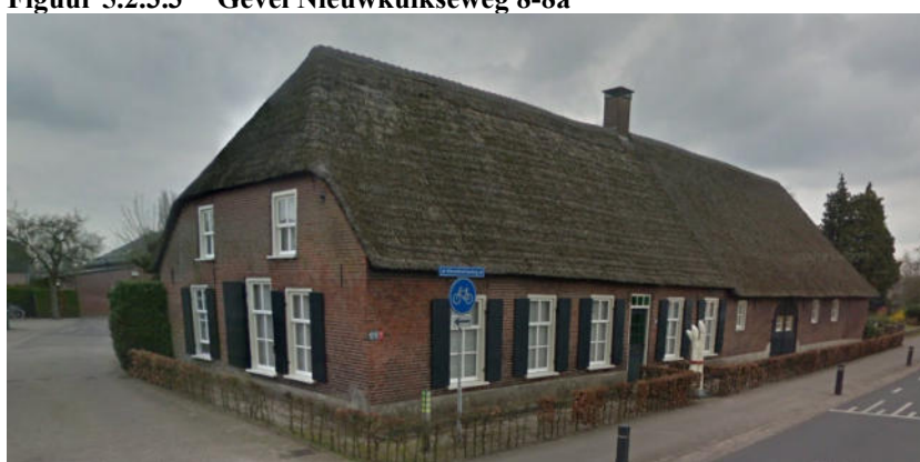
Figuur 5.2.3.4 Gevel Nieuwkuikseweg 7-7a
