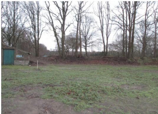
Figuur 2.3.5 Ter hoogte van het plangebied is de Cromvoirtsedijk deels verzakt en ontbreekt onderbeplanting.
