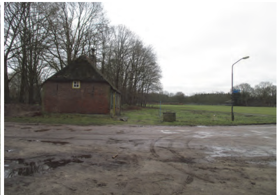
Figuur 2.3.6 Het monumentale pand staat vlak aan de weg en tegen de dijk aan.
