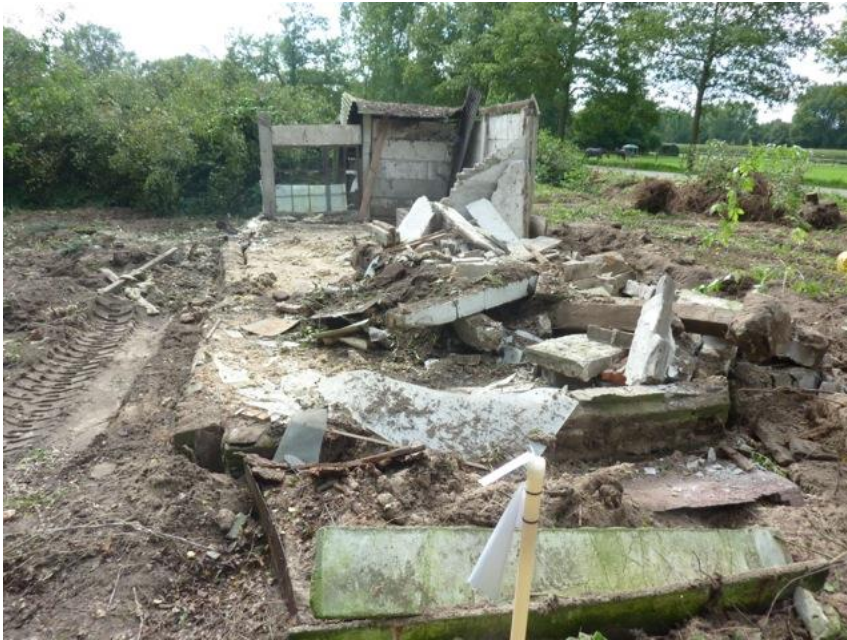
Figuur 7: De fundering van de voormalige kippenschuur vóór afbraak hiervan (bron: opdrachtgever).
