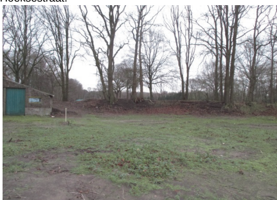
Ter hoogte van het plangebied is de Cromvoirtse Dijk deels verzakt en ontbreekt onderbeplanting.
