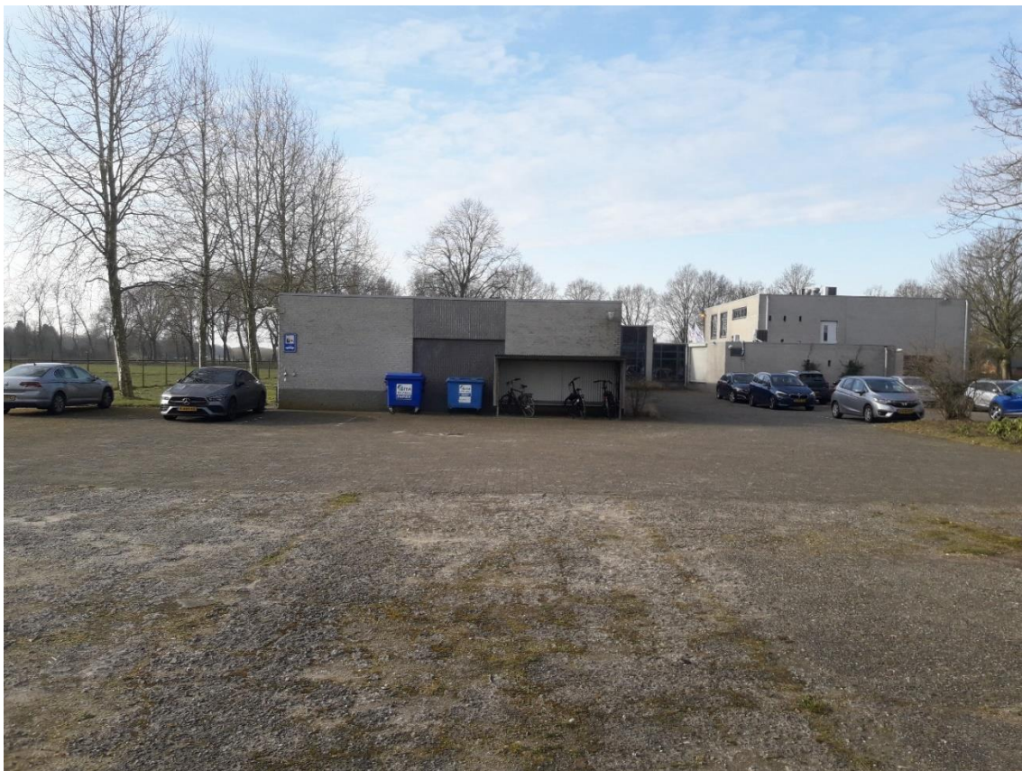
Afb. 3.3 Deelgebied B gezien vanuit het noorden (16 maart 2022).
