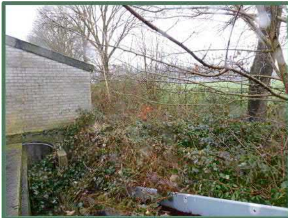
Ruigte langs stal 1 met ingang via mestkanaal
