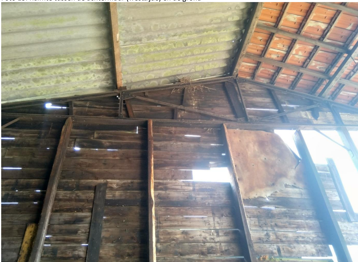
Foto 14: De noordelijke kopse gevel van de kapschuur met een duivennest.
