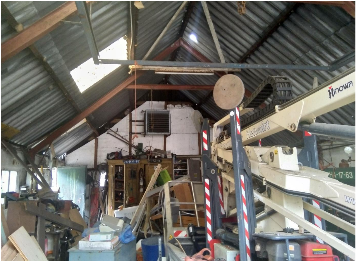
Foto 7: Overzichtsfoto van de binnenkant van de tuinschuur kijkend naar het westen. Met links de deur van de schuur en het isolatiemateriaal (witte delen) op de kopse gevel dat niet uitsluit met de daklijn.
