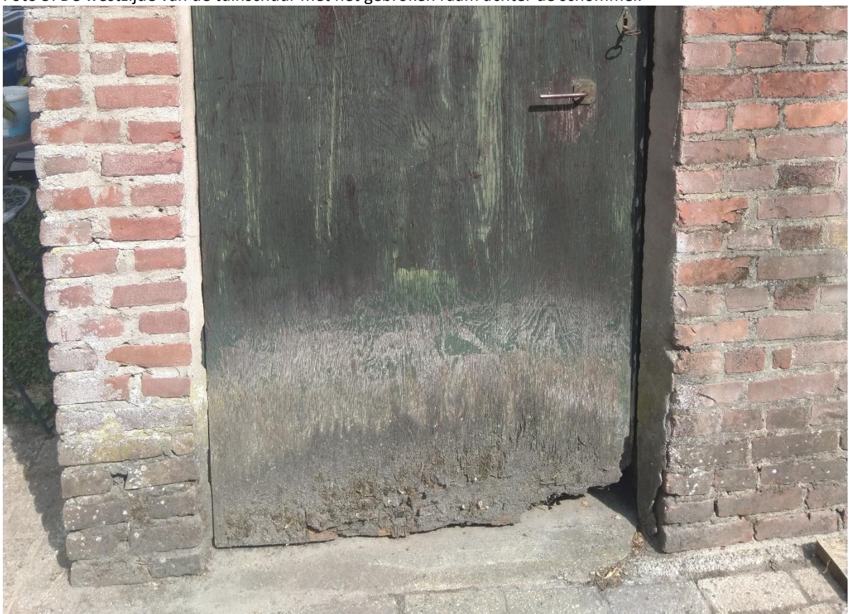
Foto 6: De deur van de tuinschuur die rechtsonder deels is weggerot.
