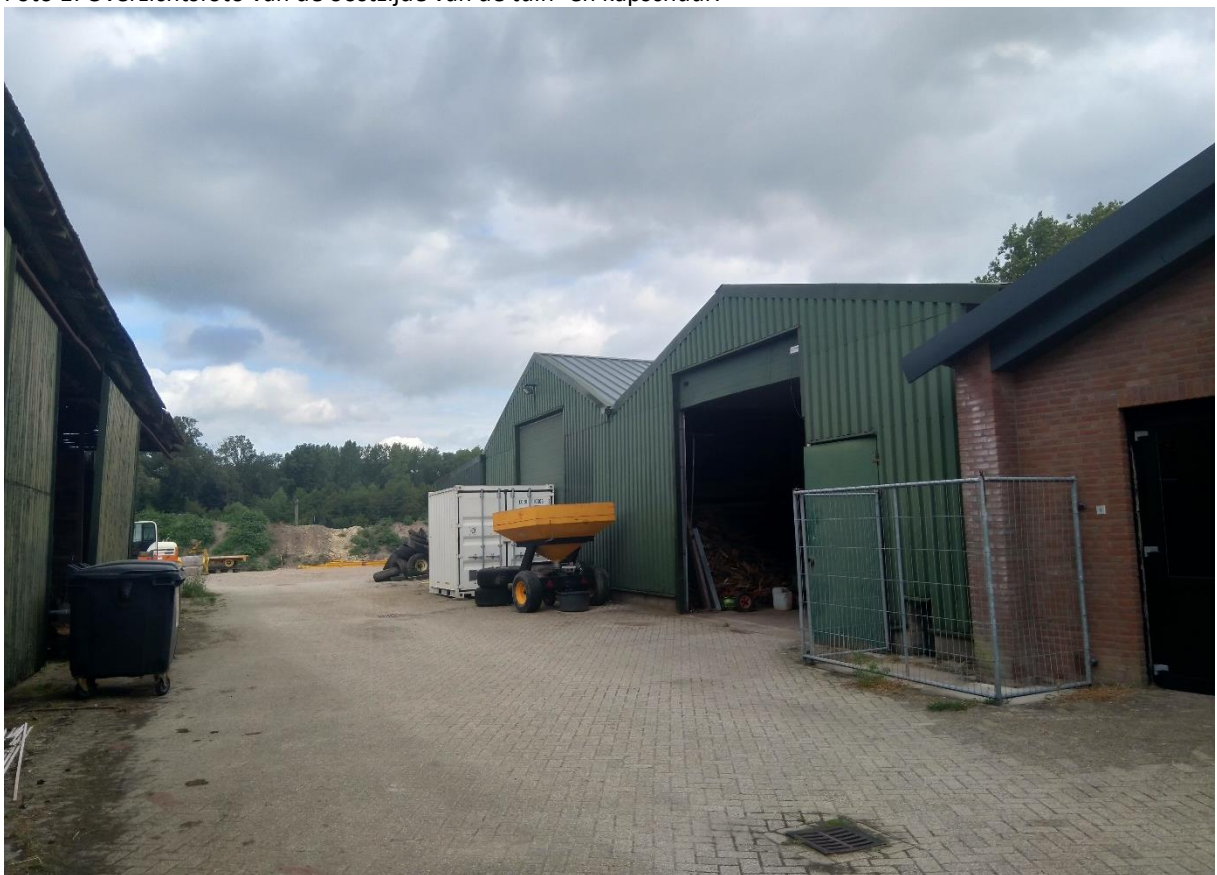
Foto 2: Overzichtsfoto van de westzijde van opslagschuur met rechts de machinestalling (stenen gebouw) en links de kapschuur.
