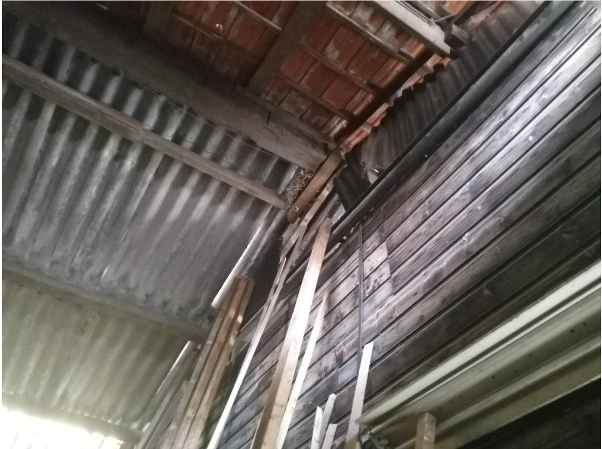
Foto 18: Duivennest aan de noordzijde van de meer afgesloten ruimte van de kapschuur.
