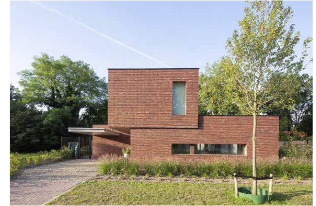
Figuur 48 Hedendaagse villa met terughoudende variëteit in materiaalgebruik
