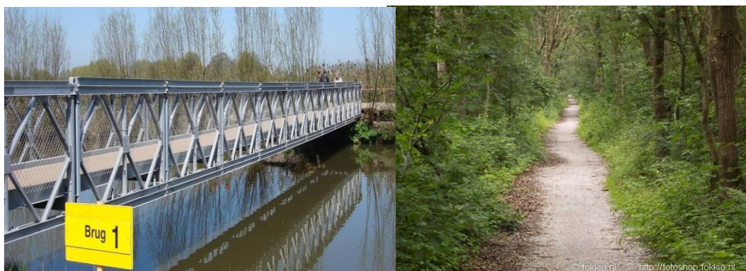
Afbeelding 1.2. Voorbeeld aan te leggen Baileybrug en aan te leggen wandelpad.
