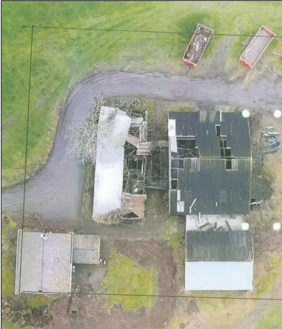
Afbeelding 3: Drone-foto voormalige agrarische bedrijfsbebouwing Molenstraat 15, Helvoirt, voorafgaand aan sloop.
