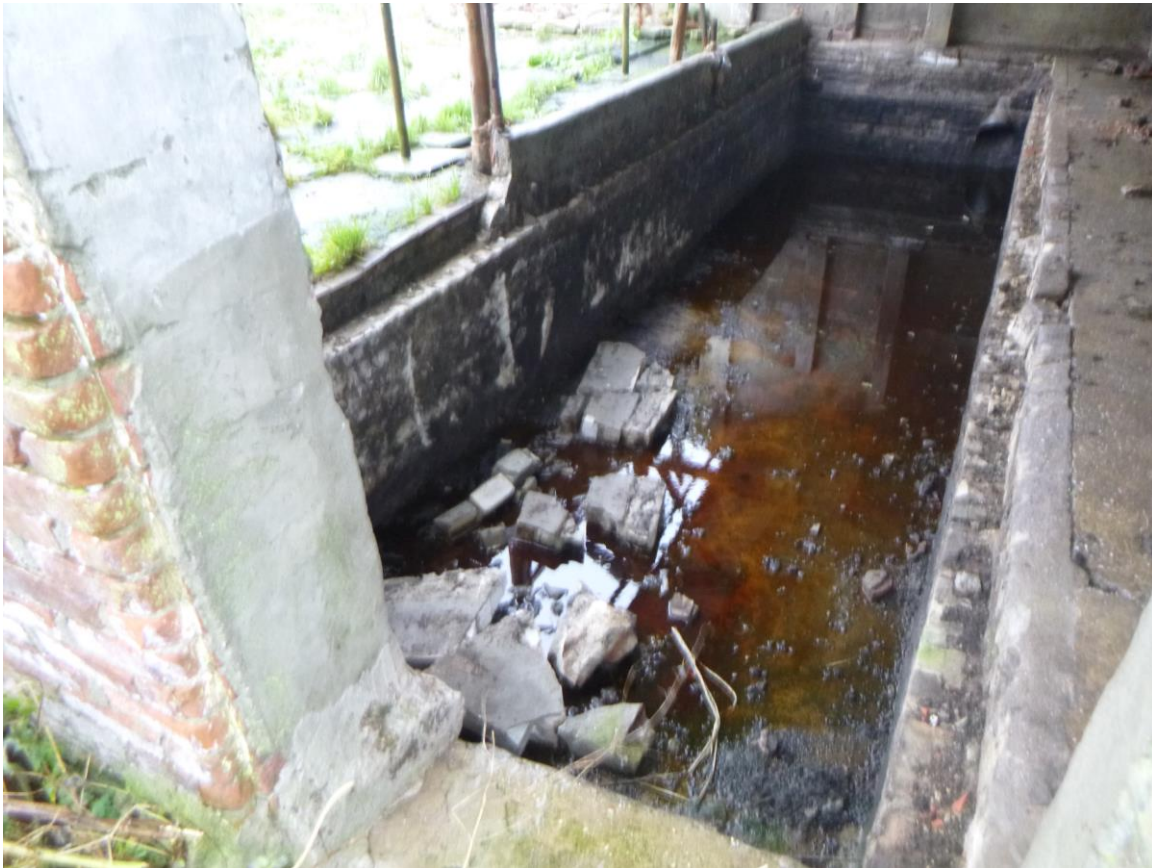
Figuur 35: Foto van één van de tenminste deels onderkelderde stallen op het centrale deel van het plangebied.
