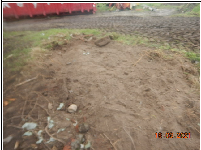
Foto 6. Verwijderde bron: B3.
