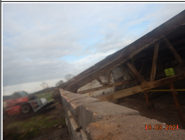
Foto 12. Herstel van foto 8 t/m 11 muurplaat verwijderd.
