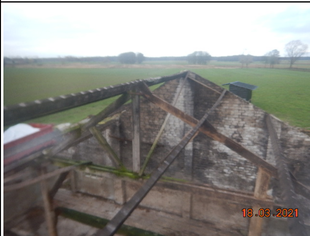
Foto 3. Verwijderde bron: B1.
