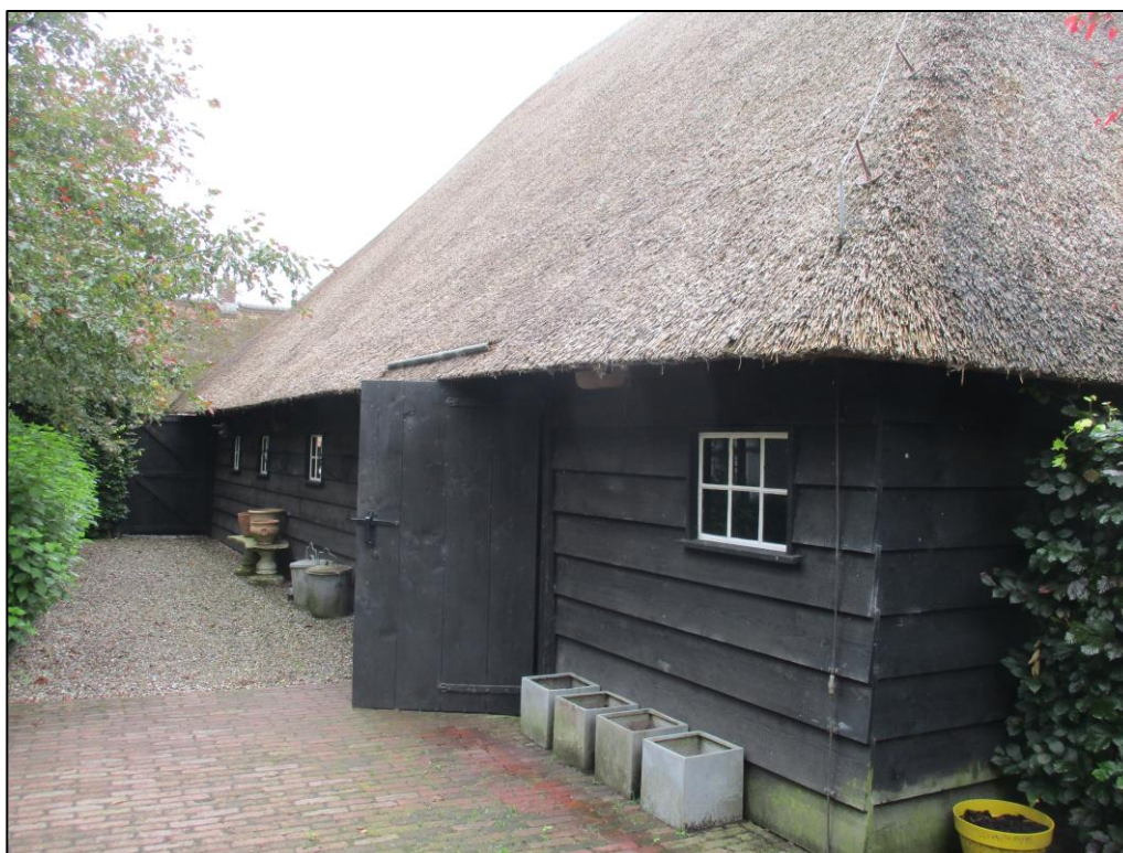
Figuur 2 De noordzijde van de te renoveren schuur. De schuur bestaat voornamelijk uit houten muren en een rieten dak.
