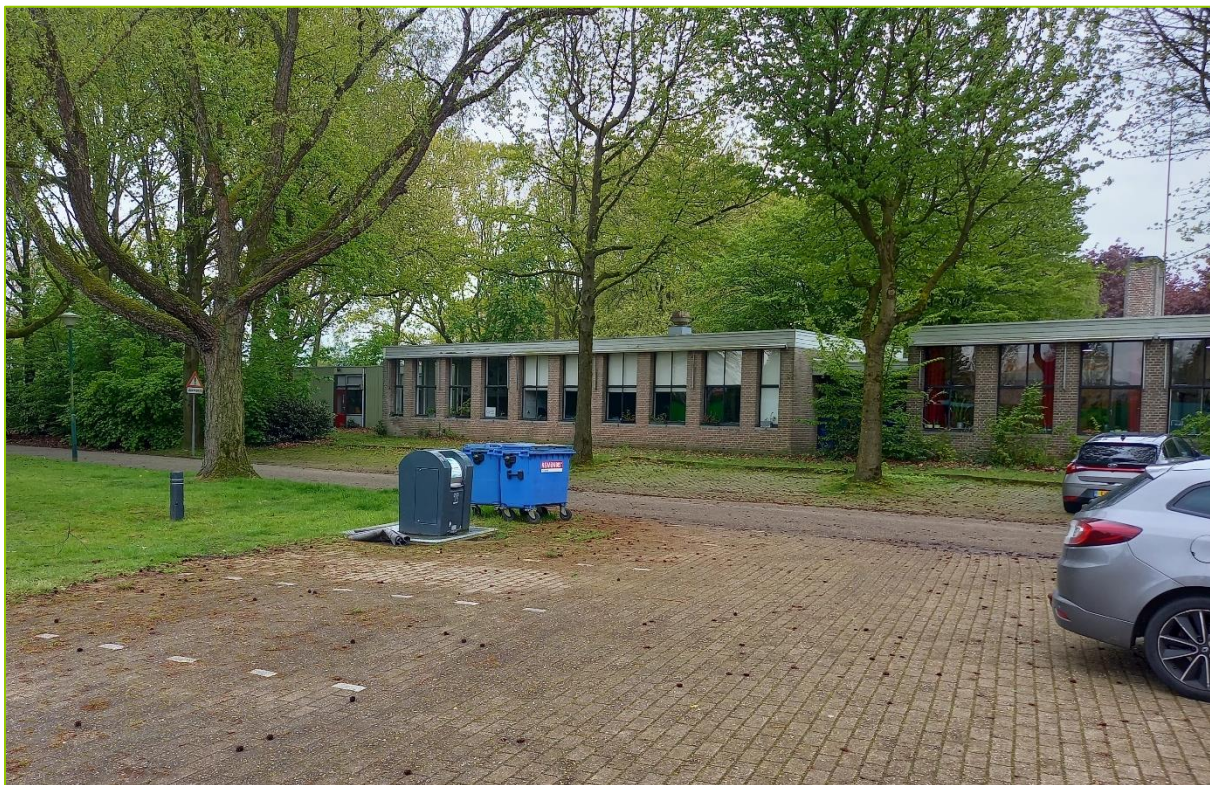
Het plangebied betreft een schoolgebouw aan de Blaarthemseweg 83 te Veldhoven.
