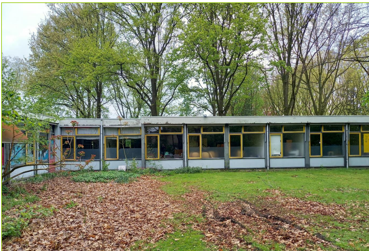
Een deel van de gevels zijn opgetrokken uit en afgewerkt met plaatwerk.
