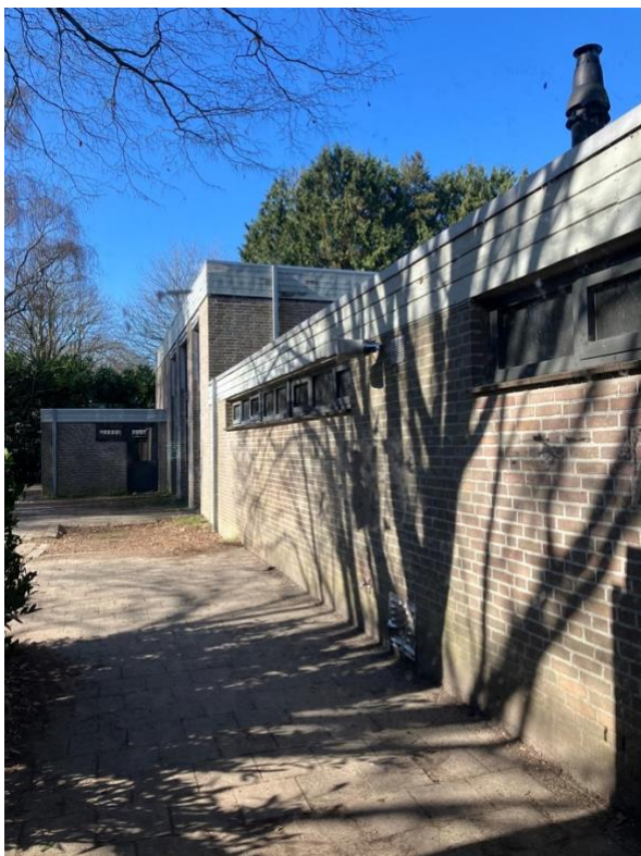
Vleugel met gymzaal
