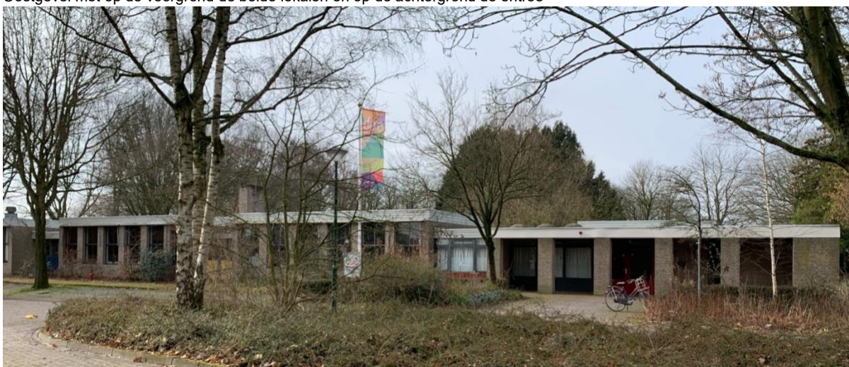
Oostgevel met op de voorgrond de overdekte entree met kolommenreeks
