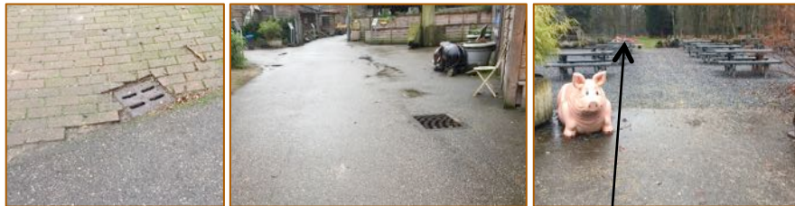
Afbeelding F: Rode lijn is riolering Foto's rechts de putten Foto's onder: diverse gierkelder
