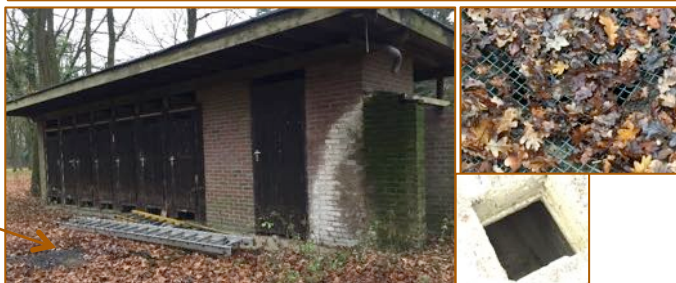
2 Foto's rechts : Gierkelder met opening bij toiletgebouw voormalige camping 3 Foto linksonder: toiletgebouw voorzien van gierkelder 4 Foto onder midden: 'deksel'
