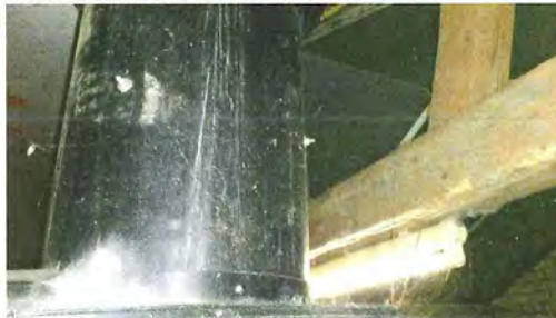
Foto 6 binnen aanzicht dak varkensstal 2
