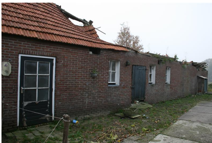
Achtergevel bedrijfs gedeelte
