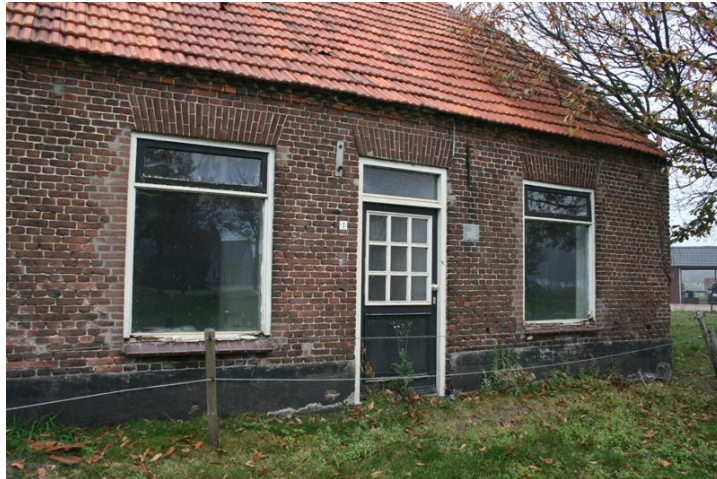
Woongedeelte met iets te smalle strekse bogen boven de vensters
