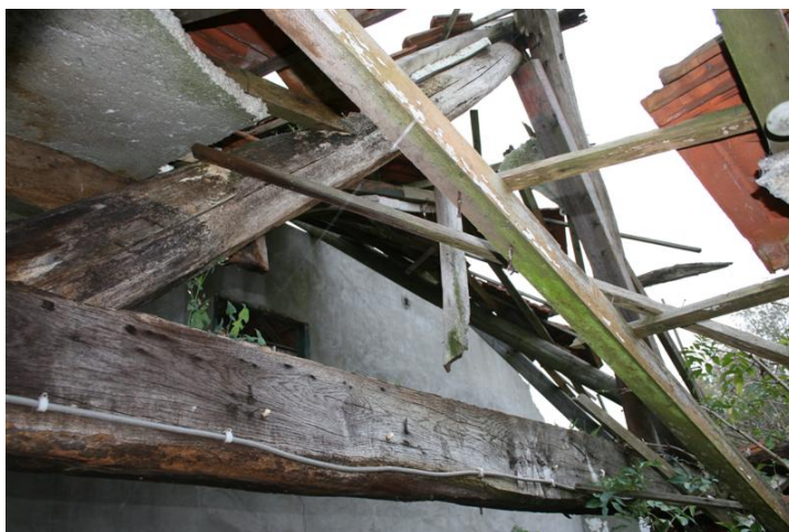
Dwarsbalk in het voormalige bedrijfsgedeelte
