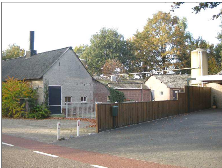
Figuur 8. De schuur die thans verloren is gegaan, met de daar achtergelegen stallen.
