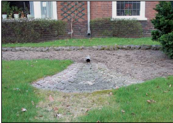
Figuur 41. Voorbeeld van een infiltratieveld.
