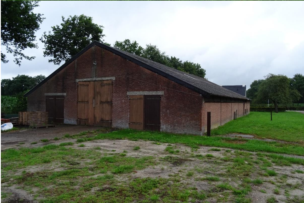
Afbeelding 3 en 4: Bestaande oude te slopen stallen op het kavel. Bron: R.J.L. Bijvelds 10-07-2020
