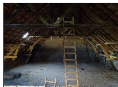
Figuur 8. Binnenkant van de zolder in de te renoveren schuur.
