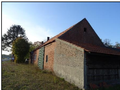
Figuur 3. Zuidelijk aanzicht onderzoekslocatie.
