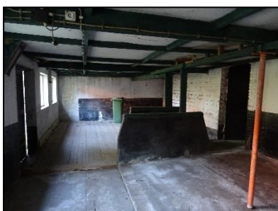
Figuur 6. Binnenkant van de te renoveren schuur.
