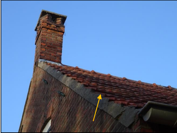
Figuur 13. Ruimtes onder de dakpannen zijn toegankelijk voor vleermuizen.
