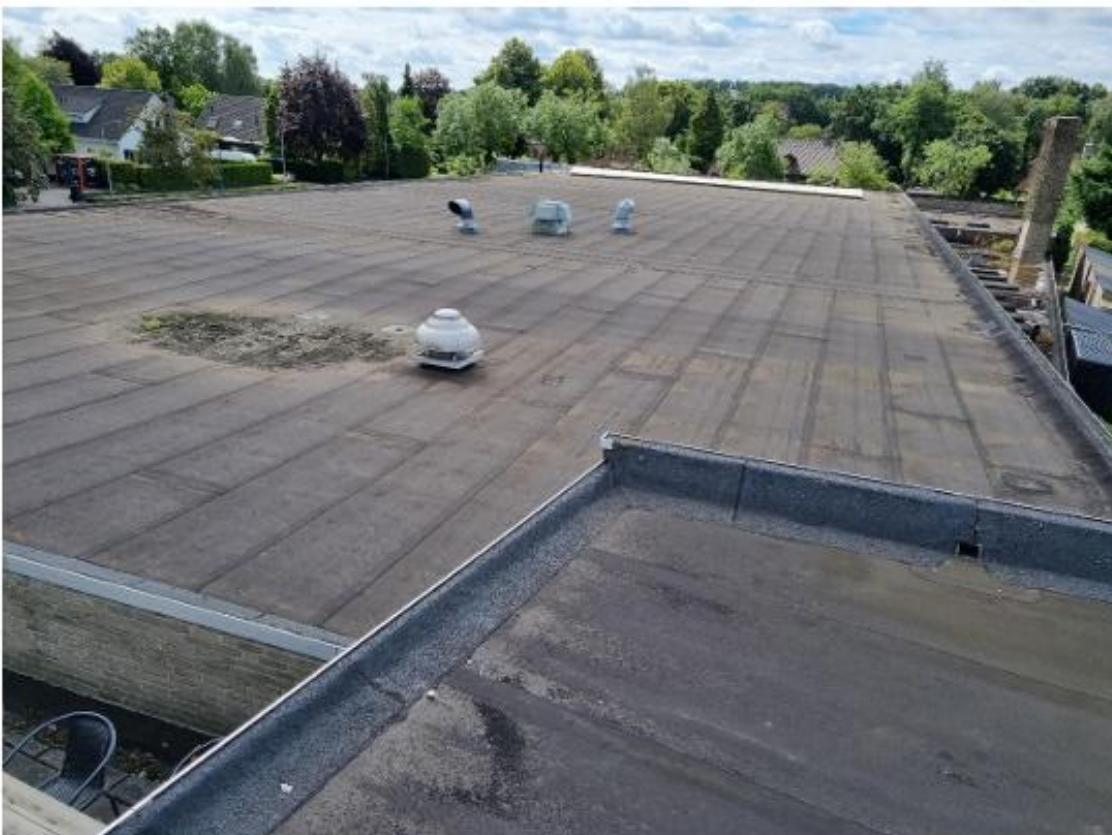
Foto 6: overzicht van het dak
