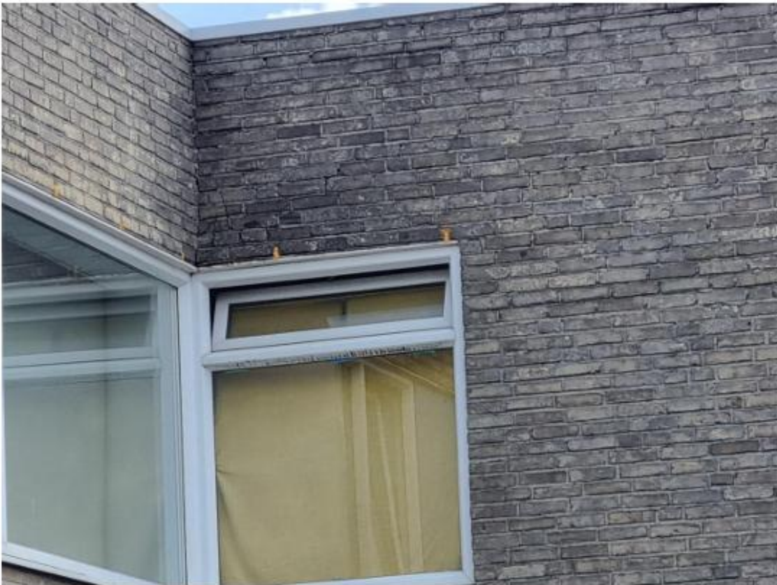
Foto 5: afgedichte stootvoegen bij appartementen
