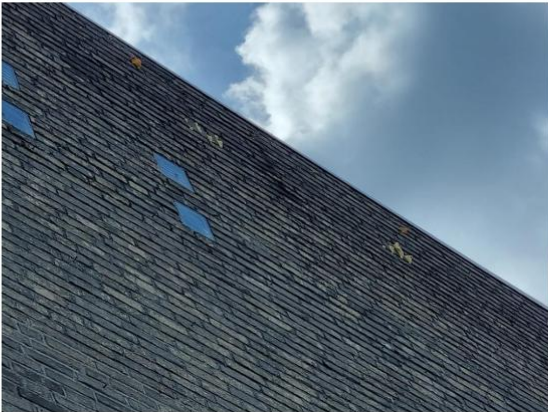
Foto 8: afgedichte openingen in westelijke gevel
