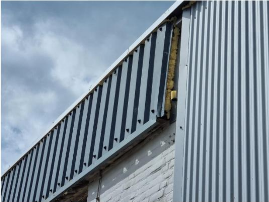
Foto 9: afgedichte opening in oostelijke zijde van bebouwing
