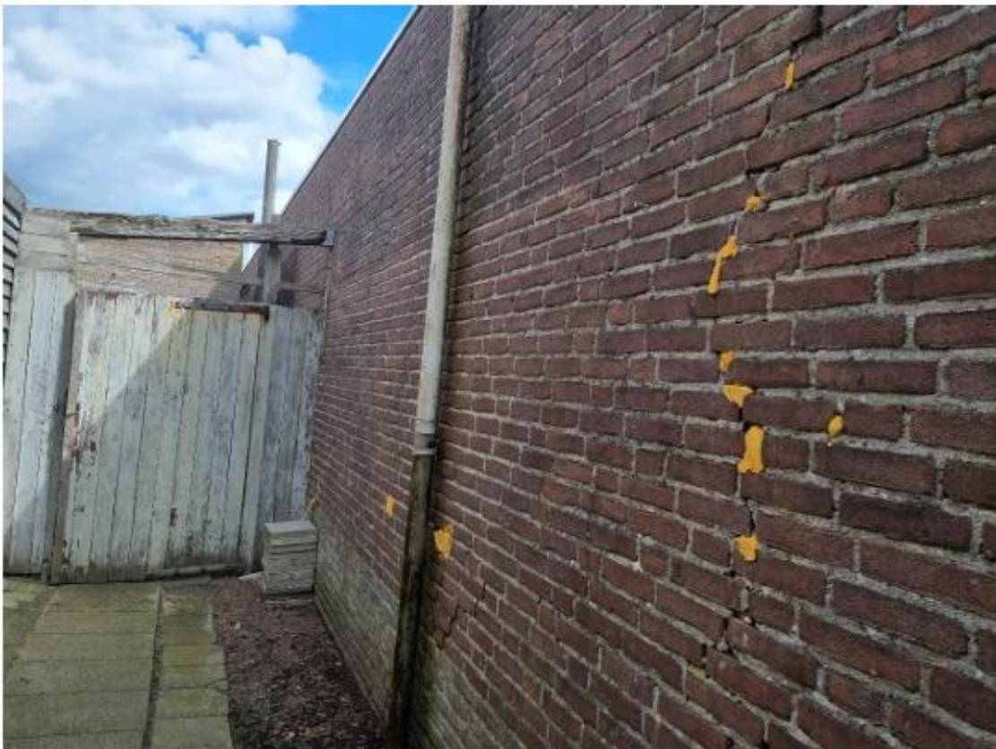
Foto 10: westelijke gevel van bebouwing
