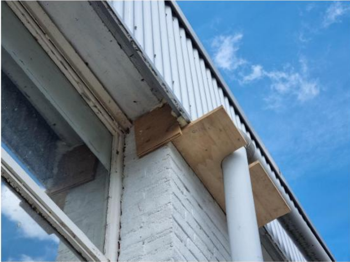
Foto 7: afgedichte openingen in de gevel van de loods
