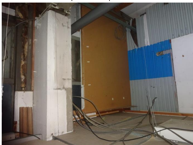
Inspectie boven plafonds
