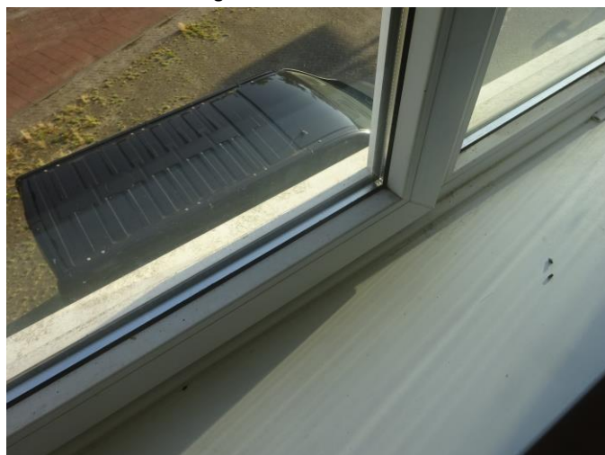
Glasafdichting in rubbers of niet asbestverdacht
