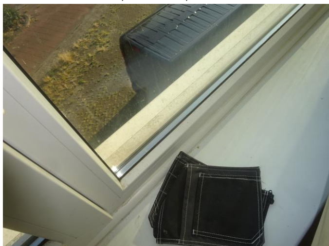
Glasafdichting in rubbers of niet asbestverdacht
