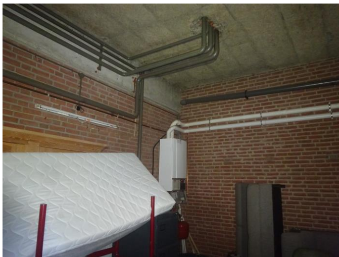
Installaties niet asbestverdacht
