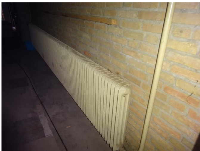
Radiatoren niet asbestverdacht
