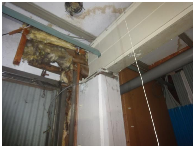
Inspectie boven plafonds
