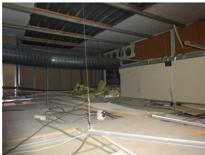
Inspectie boven plafonds
