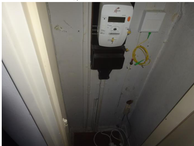
Installaties niet asbestverdacht
