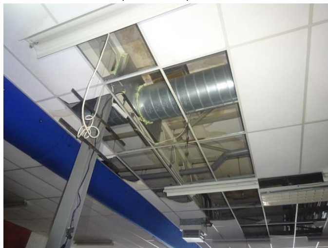
Inspectie boven plafonds
