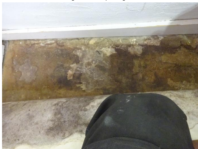
Vloerafwerkingen niet asbestverdacht
