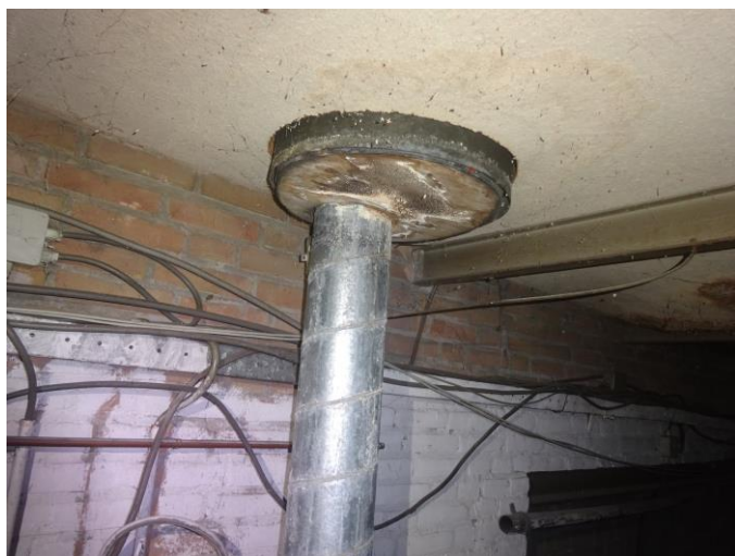
Kanalen/doorvoeren niet asbestverdacht
