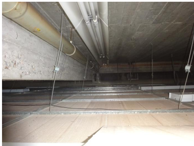
Inspectie boven plafonds
