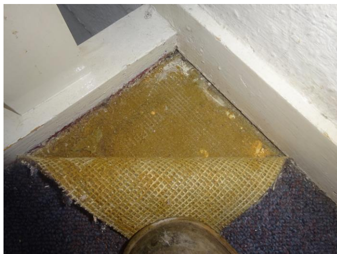
Vloerafwerkingen niet asbestverdacht
