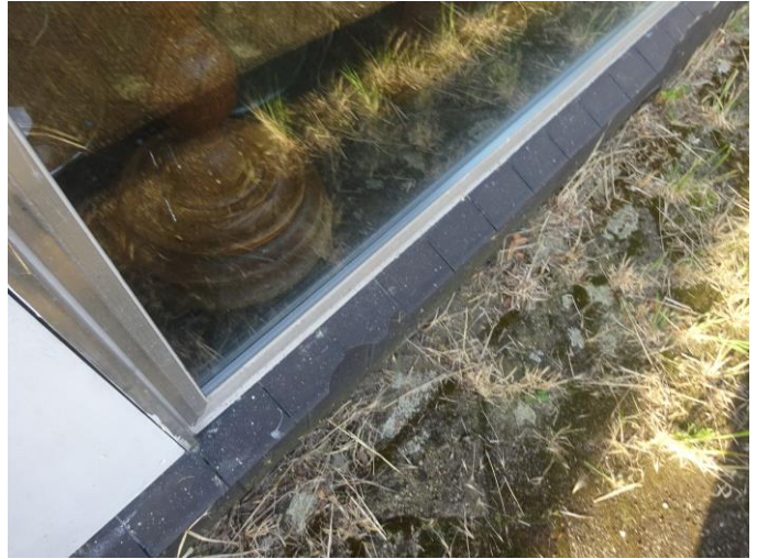
Glasafdichting in rubbers of niet asbestverdacht
