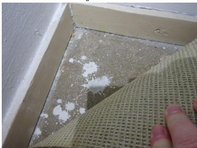
Vloerafwerkingen niet asbestverdacht
