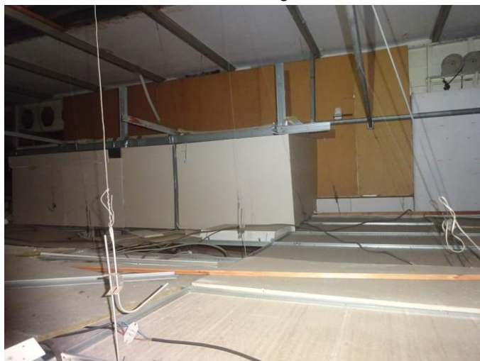
Inspectie boven plafonds
