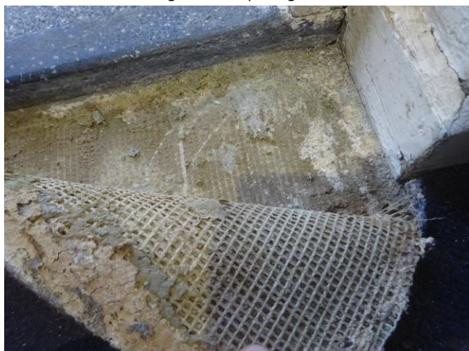
Vloerafwerkingen niet asbestverdacht
