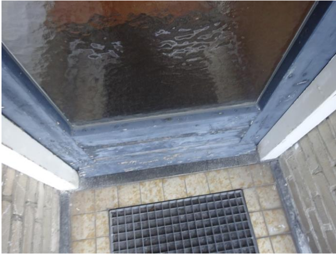
Glasafdichting in rubbers of niet asbestverdacht
