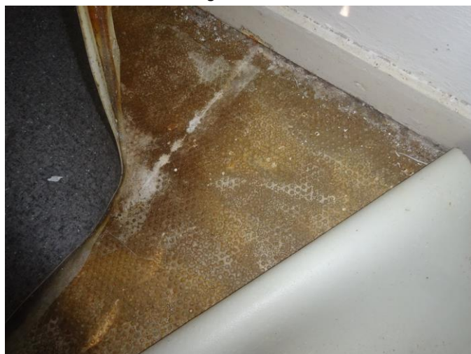
Vloerafwerkingen niet asbestverdacht
