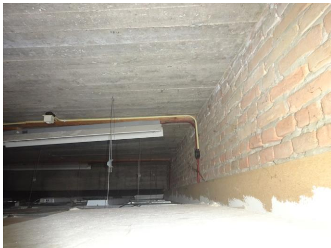
Inspectie boven plafonds
