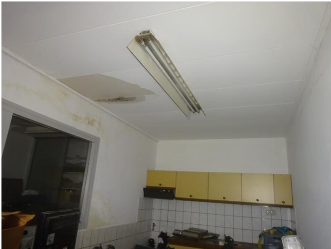
Div. wanden/plafonds niet asbestverdacht
