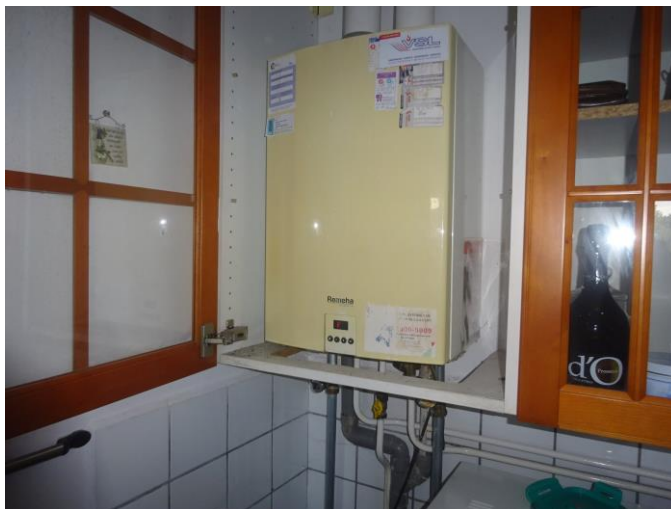
Installaties niet asbestverdacht
