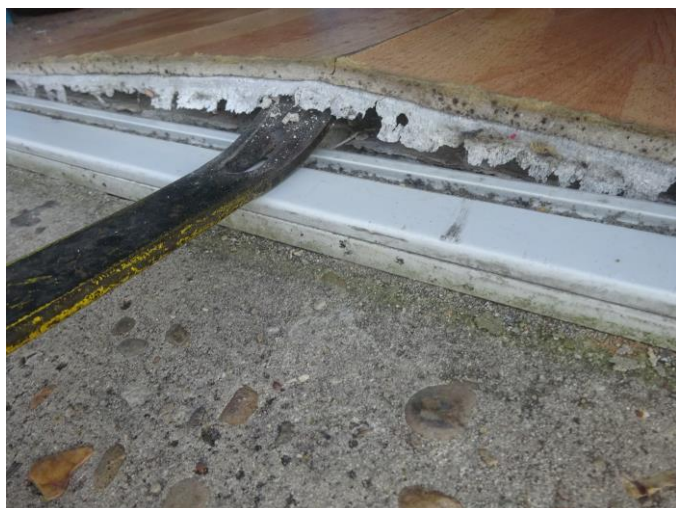
Vloerafwerkingen niet asbestverdacht
