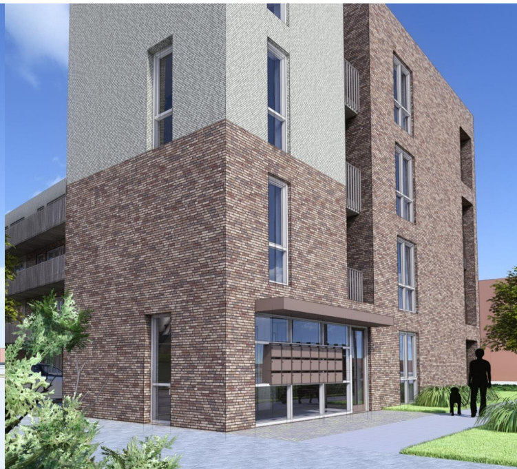
Accent ter plaatse van hoofdentree
