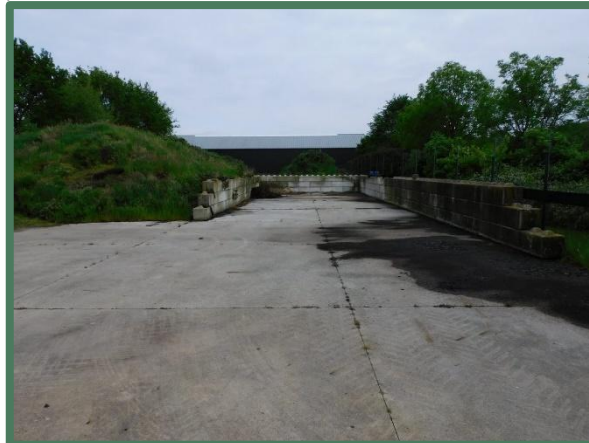
Overzicht te slopen sleuvsilo
