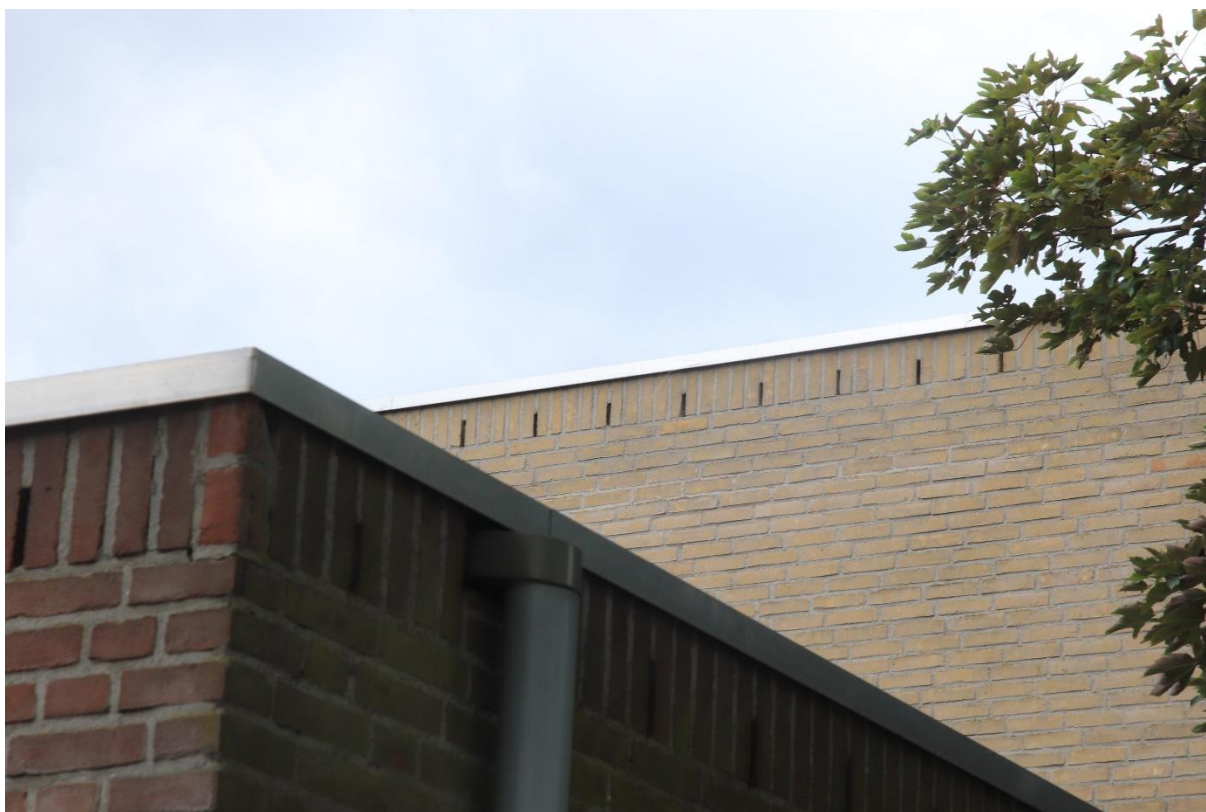
Foto 2: De dakbedekking van de overige gebouwen bestaat uit een plat dak, met bitumen afdekking en is afgewerkt met strak gemonteerde aluminium strips waar geen ruimte onder zit voor soorten als gierzwaluw, huiszwaluw en andere soorten vogels (al of niet met jaarrond beschermde nesten).
