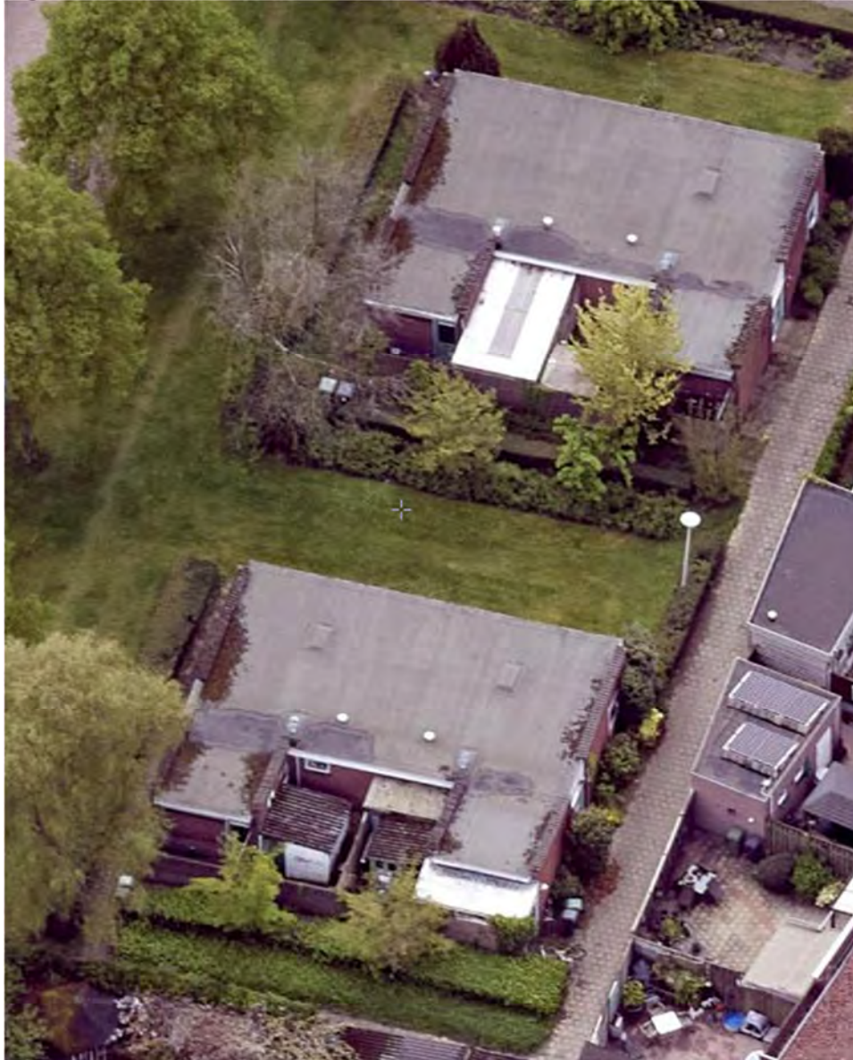
Figuur 2.14: luchtfoto onderzoekslocatie Hertog van Brabantstraat 2, 4, 6 en 8
