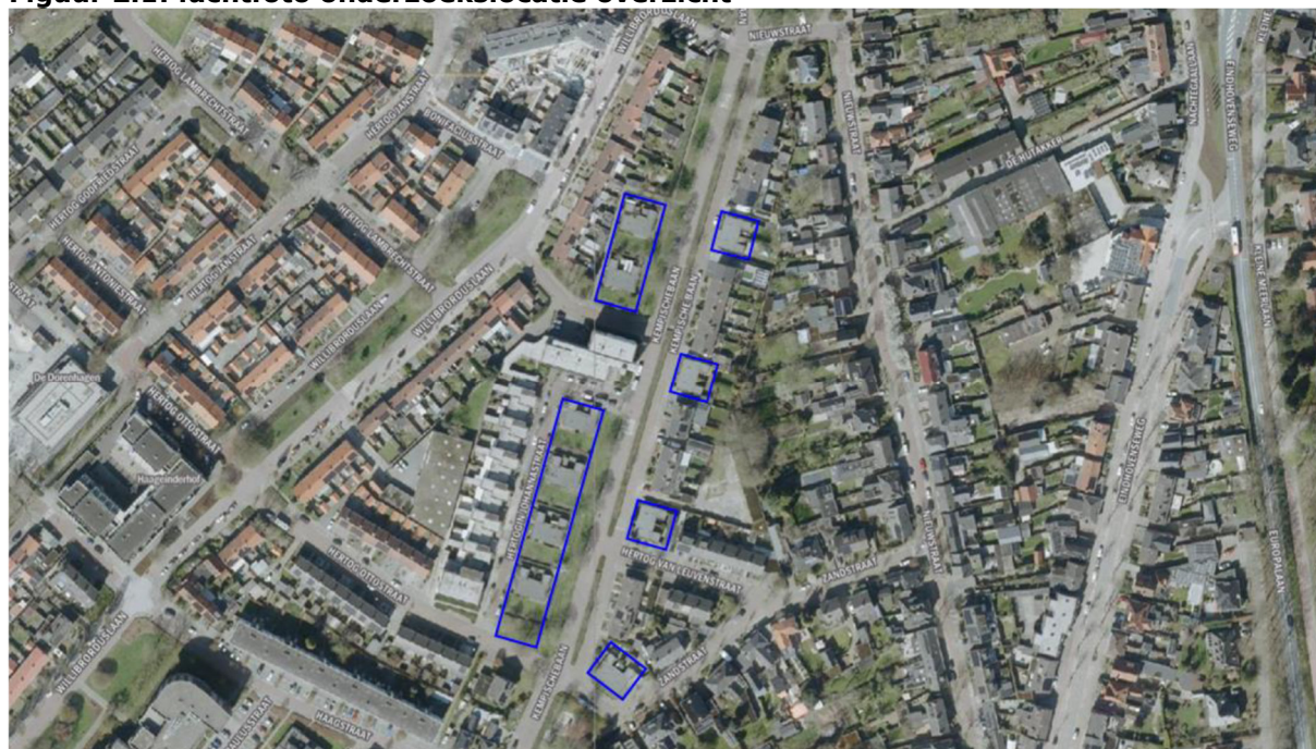
Figuur 2.1: luchtfoto onderzoekslocatie overzicht
