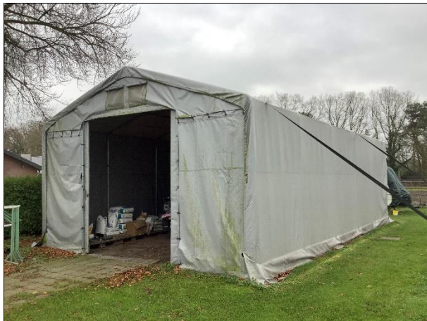
Foto 3 De tent kijkend naar de noord- en westgevels.
