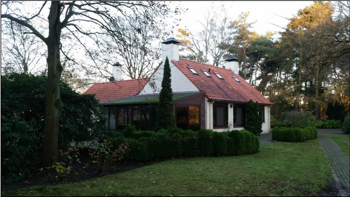
Huidige situatie woning oostzijde
