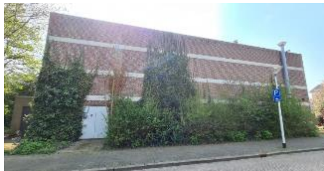
Figuur 5: Noordgevel van het zalencentrum
