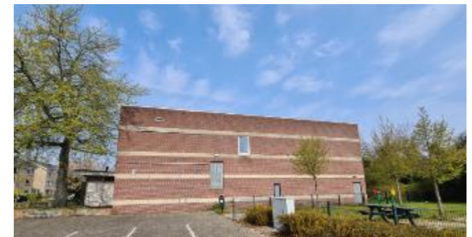
Figuur 6: Zuidgevel van het zalencentrum
