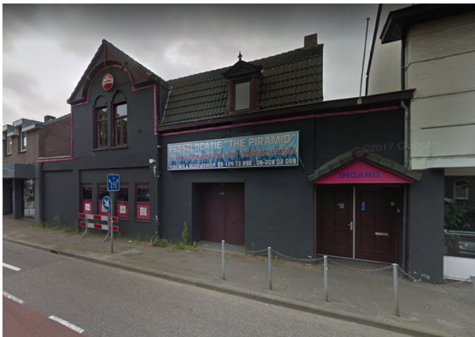
Figuur 4.2. Bestaande bebouwing (Bron: Google maps)
