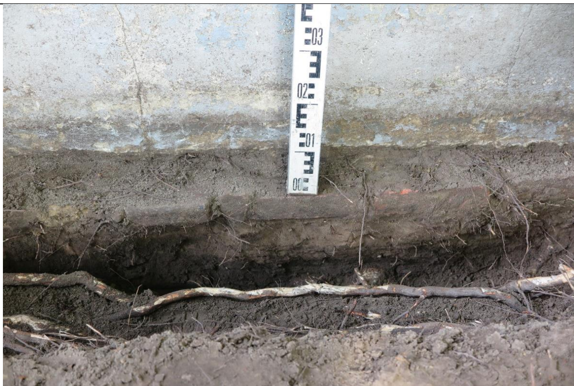
Beeld van de zeer lichte fundering (of ontbreken van de fundering..)
