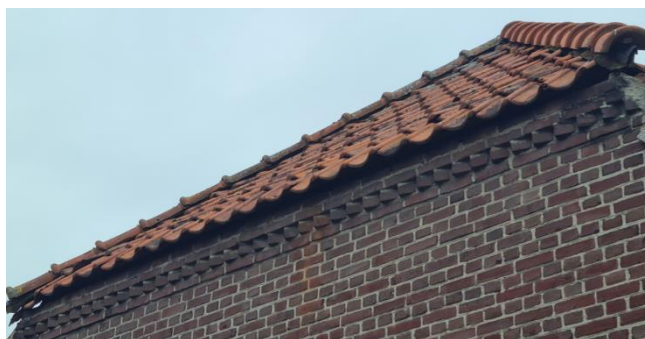
Figuur 8: Detailopname dakrand oostgevel
