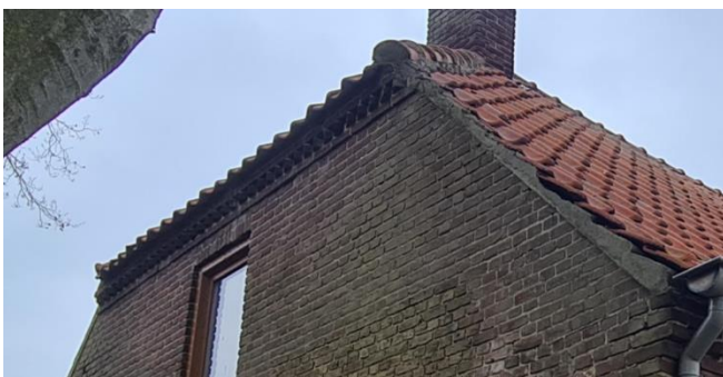
Figuur 7: Detailopname dakrand westgevel
