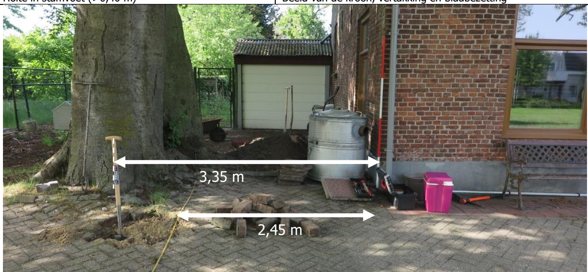
Afstand hart boom tot gevel bebouw ca. 3,35 m
