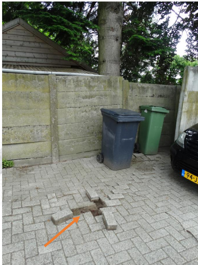
Afbeelding 6 Tot 160 cm westwaarts bevinden zich wortels die de bestrating omhoog duwen.
