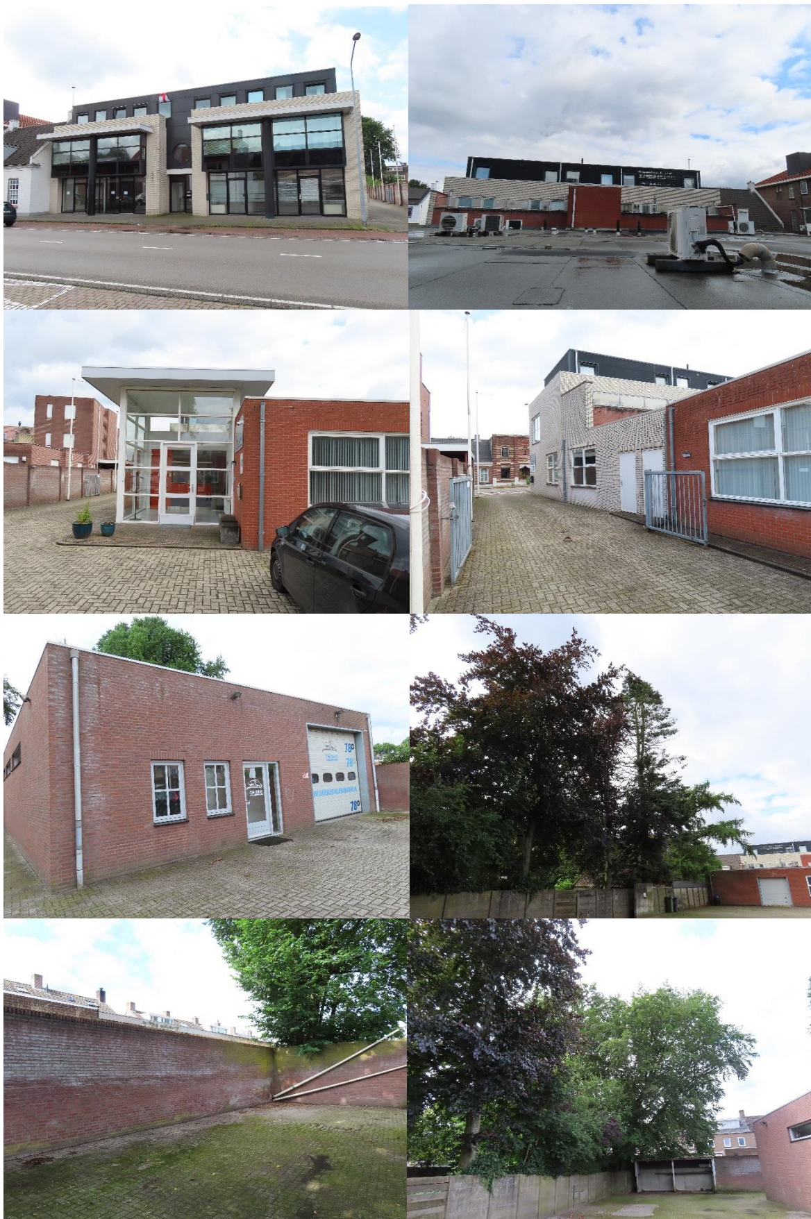
Afbeelding 3 t/m 11: Bestaande te verbouwen bebouwingen. Bron: BNL advies.
