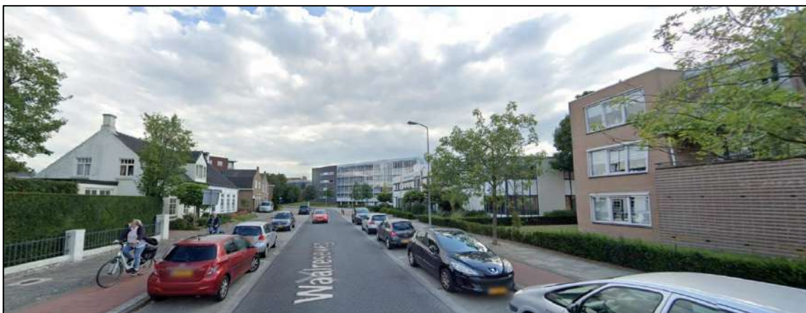
Zicht vanuit de kruising Waalreseweg/Kerkhofstraat/Gasthuisstraat op het plangebied. Het tweede pand aan de rechterzijde is het plangebied. (Bron: https://www.google.nl/maps , streetview)
