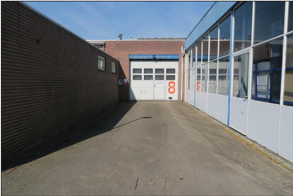
Figuur 1 De loods (rechts) en het pand met woonunit en garageboxen (links).
