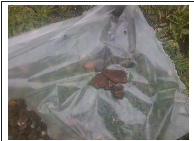
Foto 7. Asbest plaatmateriaal asbestinspectiegat A06
