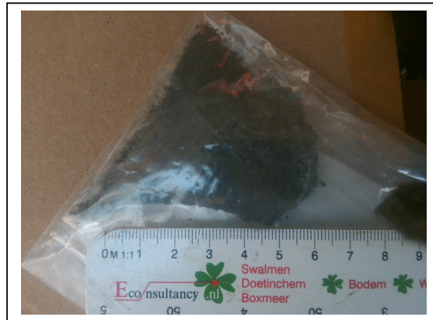
Foto 8. Asbest plaatmateriaal asbestinspectiegat A06
