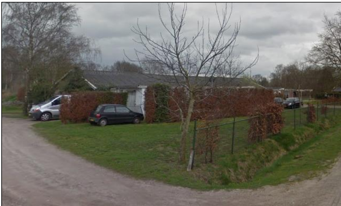
Figuur 7 Huidige situatie planlocatie (perceel 800)
