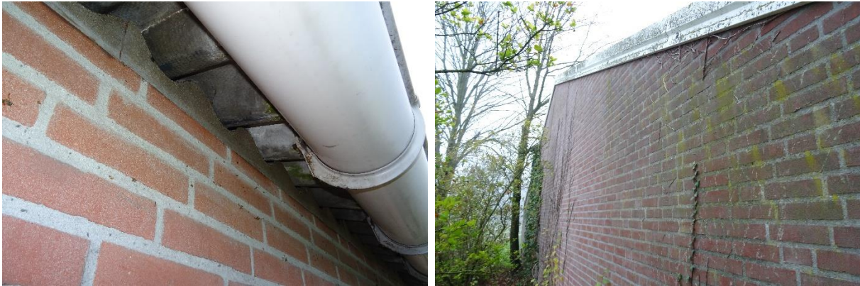
Afbeelding 12 en 13: Gesloten daken/ geen toegang tot aanwezige spouwmuur, d.m.v. vogelschroot en dakbeschoot/ daktrim sluit nagenoeg naadloos aan op de bebouwing. Bron: R.J.L. Bijvelds Datum: 02-12-2020
