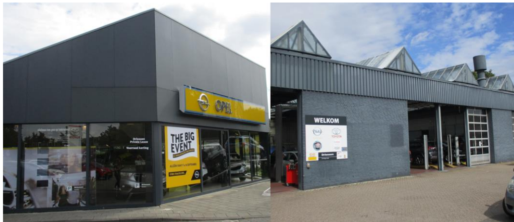
Figuur 3 Fotografische indruk van de planlocatie, met links een deel van de showroom en rechts de garage.
