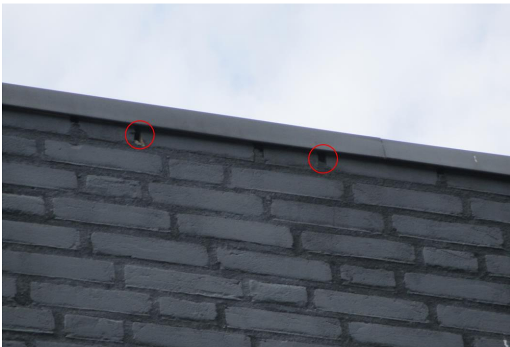
Figuur 4 De muur aan de oostzijde van de garage met metalen daklijst met daaronder openingen.
